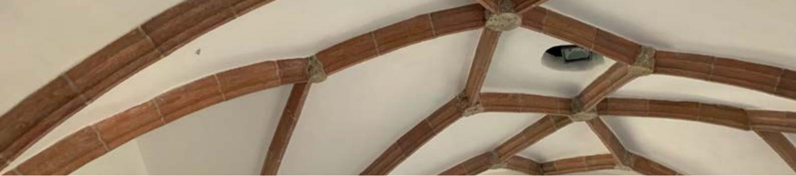
Das Netzrippengewölbe wurde gesäubert und aufpoliert. Auch die Malerarbeiten im Bereich der Decke und das gesamte Mauerwerk wurden bereits fertiggestellt. Die Restaurationsarbeiten der beiden Seitenaltäre und des Hauptaltars sind bereits begonnen und sollten zeitgerecht, wie geplant, abgeschlossen werden.
