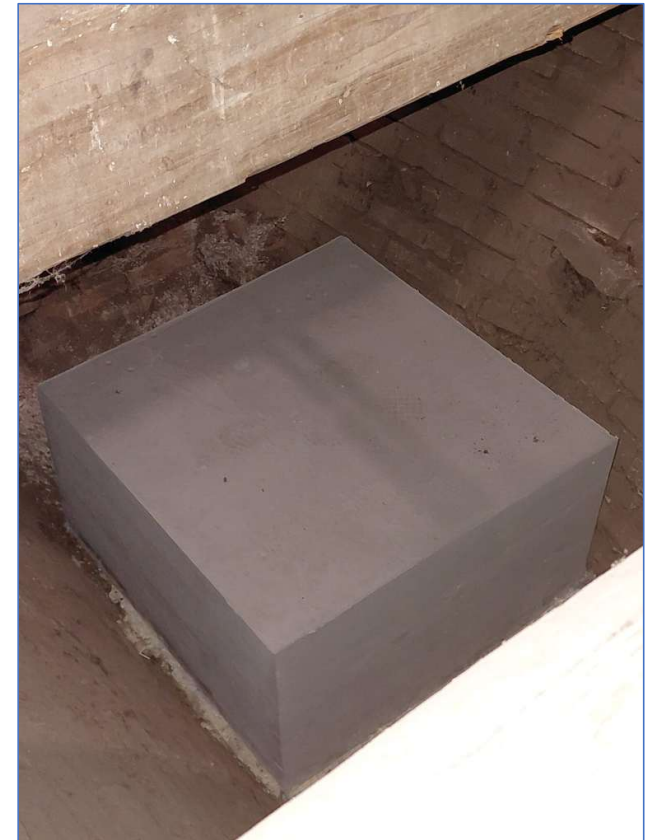
Massives Beton-Auflager über den Säulen zum Aufsetzen der Stahl-Stützen für die tragende Mittelachse.
