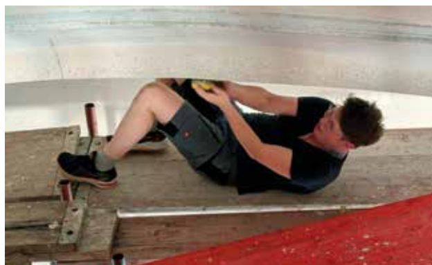
Wände durch „radieren“ für Malerarbeiten vorbereitet
