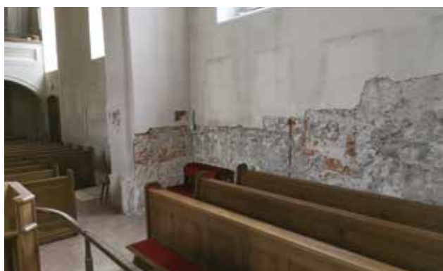
Schadhafter Verputz durch Feuchtigkeit im unteren Bereich der Wände wurde entfernt
