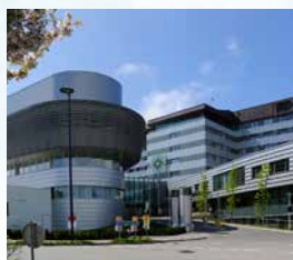
Krankenhaus Ried i.I.
