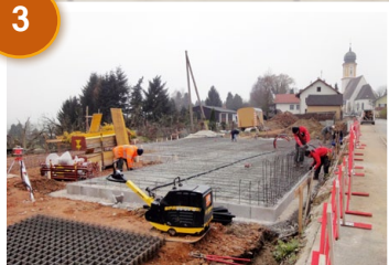
Herbst 2014: Vorbereitung des Bauplatzes
