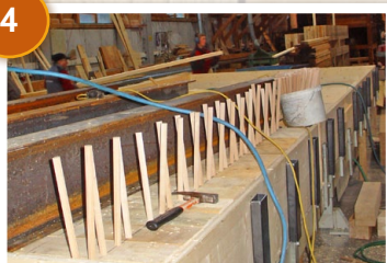
Herbst/Winter 2014: Holzteile erstellen, Dachstuhl- u. Fassadenholz schlichten, ... (Fa. Hauer, Enzenkirchen)
