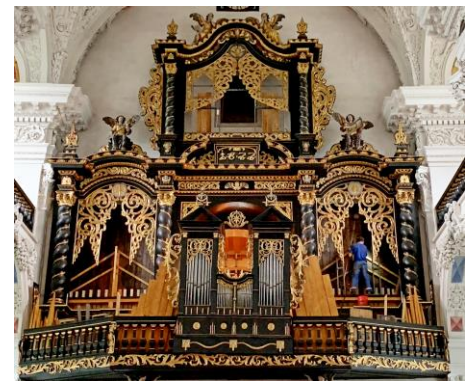
Orgel ohne Pfeifen während der Sanierung
