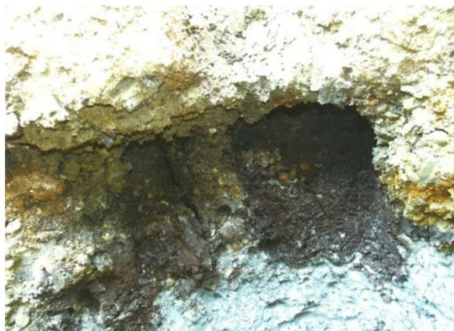
*Abgefaulte Pfahlköpfe, oben Unterkante Tuffsteinmauer*
