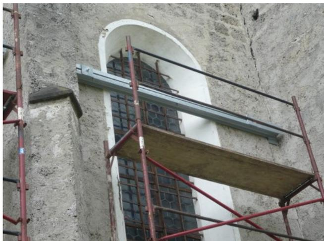
*Gewölbeverspannung, rechts Riss zw. Presbyterium und Hauptschiff*
