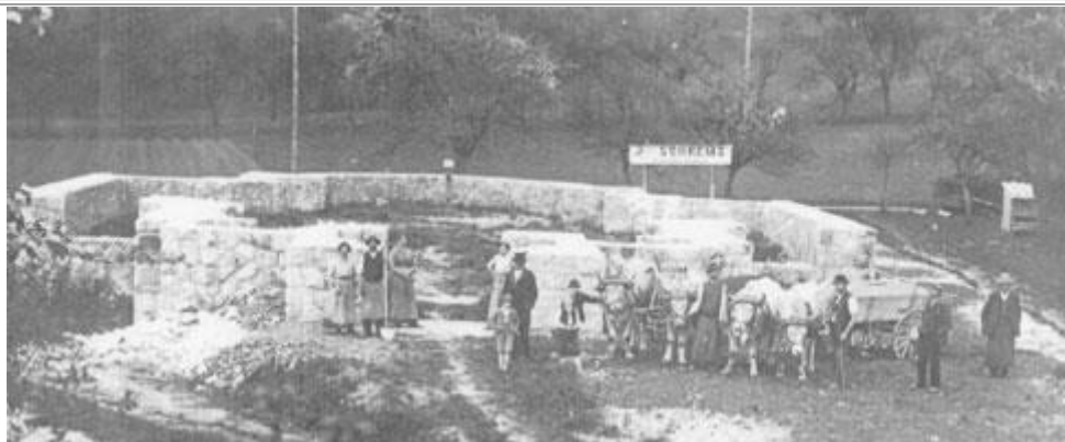
Fundament und Sockelmauerwerk aus Granit
