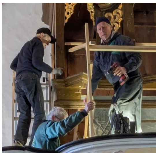
Abbildung 2 Restaurator Flanderka (rechts außen) beim Demontieren einer Folieneinhausung
