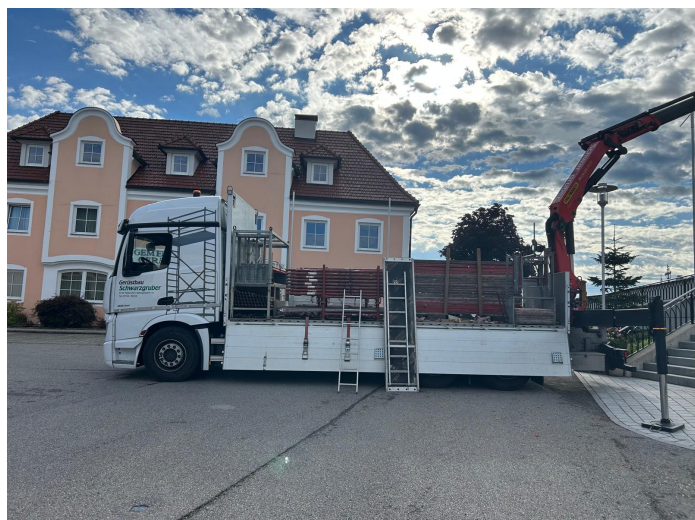
Das Gerüst ist angekommen!
