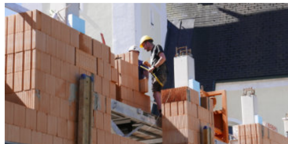
Das Erdgeschoss wird gemauert
