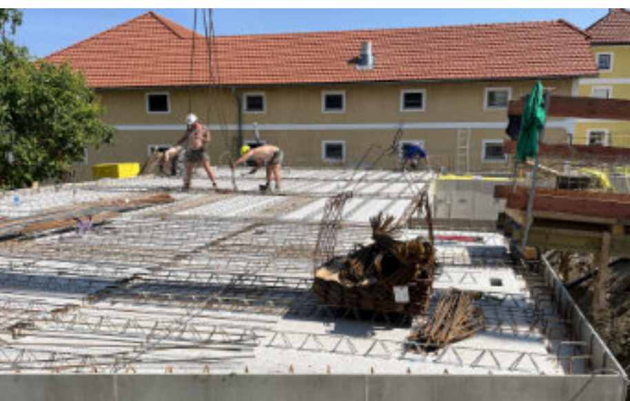
Die Kellerdecke wird verlegt und bewehrt
