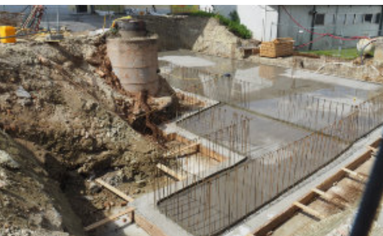
Die Bodenplatte
