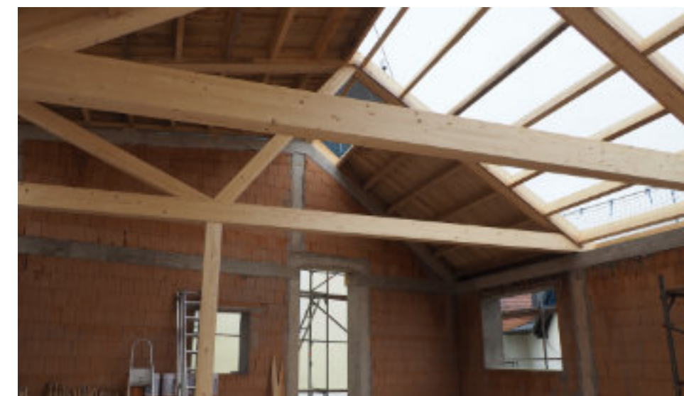
Der Dachstuhl ist gehoben und wird verschalt.
