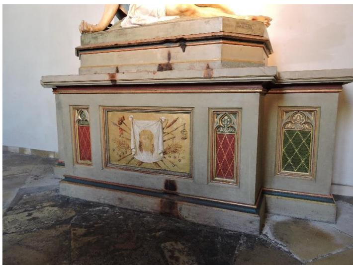
Foto 16 Unterbau nach Wachsabnahme und Konservierung
