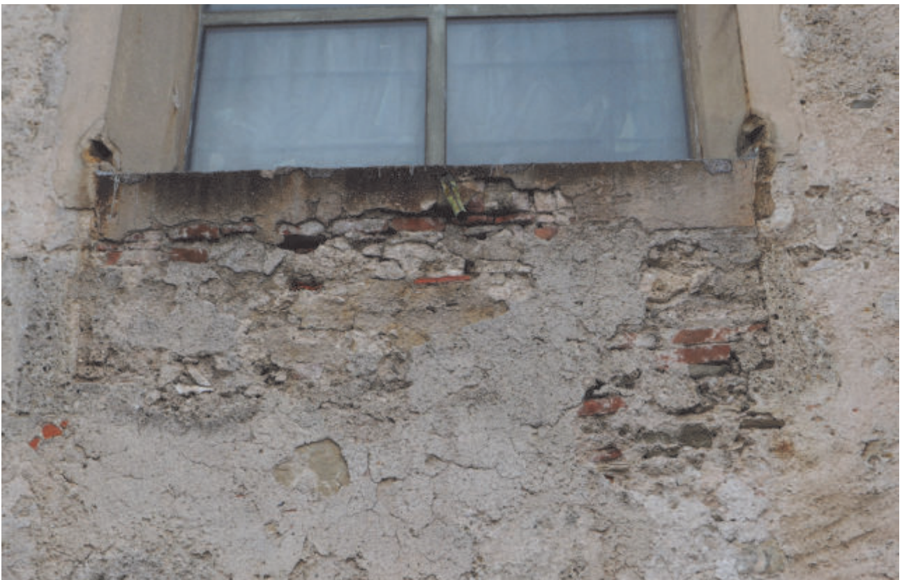
Langhaus, Nordfassade, Wandfläche über den Eingang, mit Strebepfeiler, beim östlichen Fenster war die Unterkante ehemals tiefer
