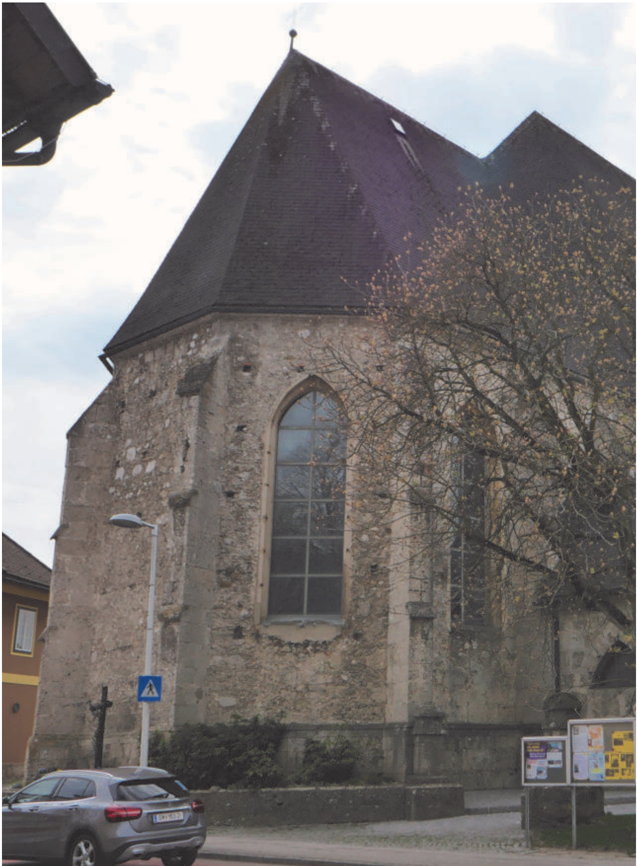
Langhaus, Ostabschluss, Ansicht Nordost
