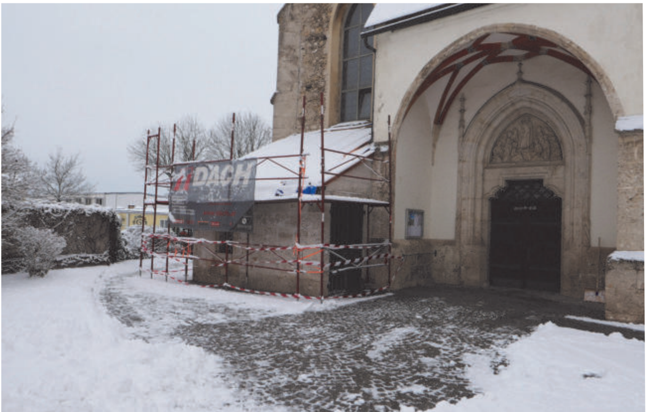
Langhaus, Südfassade, Fotos Feb. 2026
