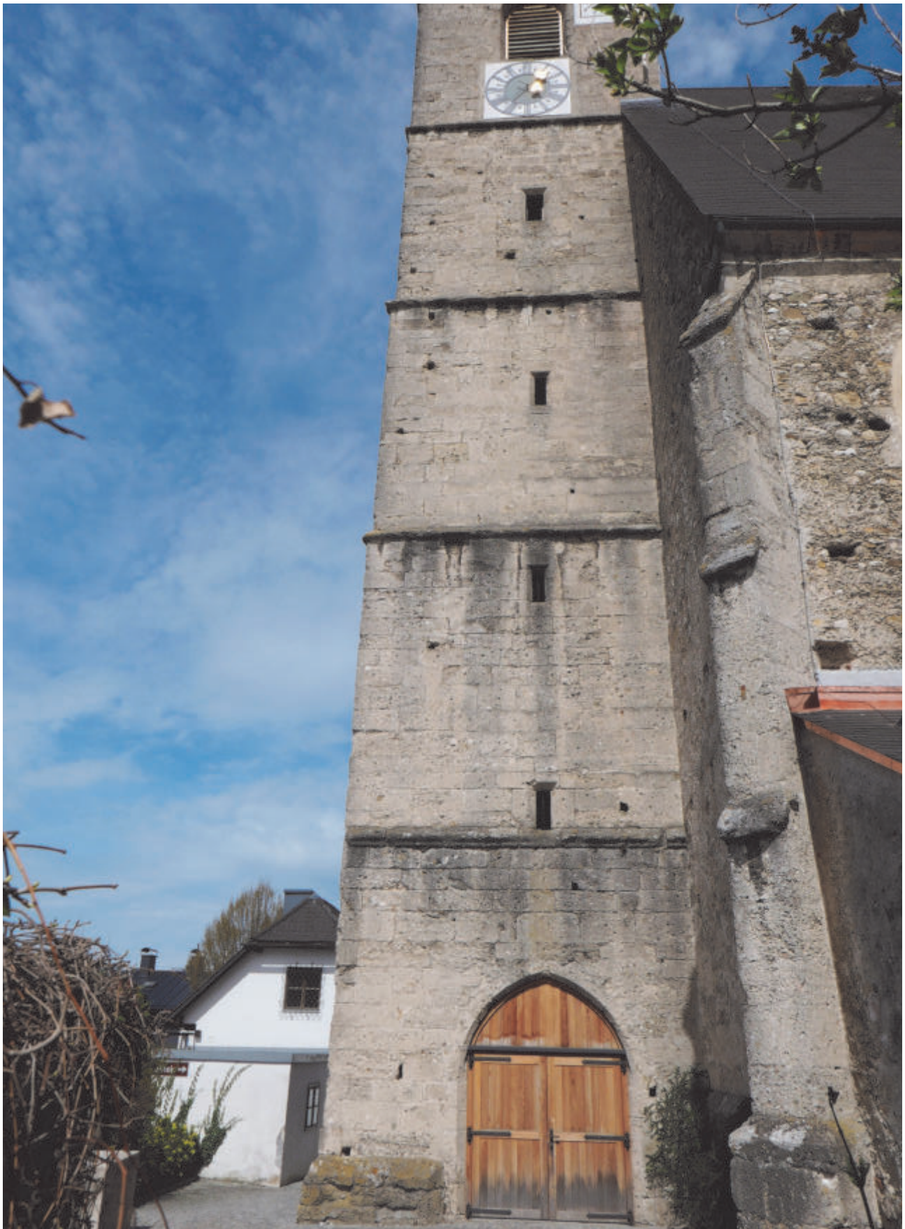
Turm, Südfassade, Gesamtansicht
