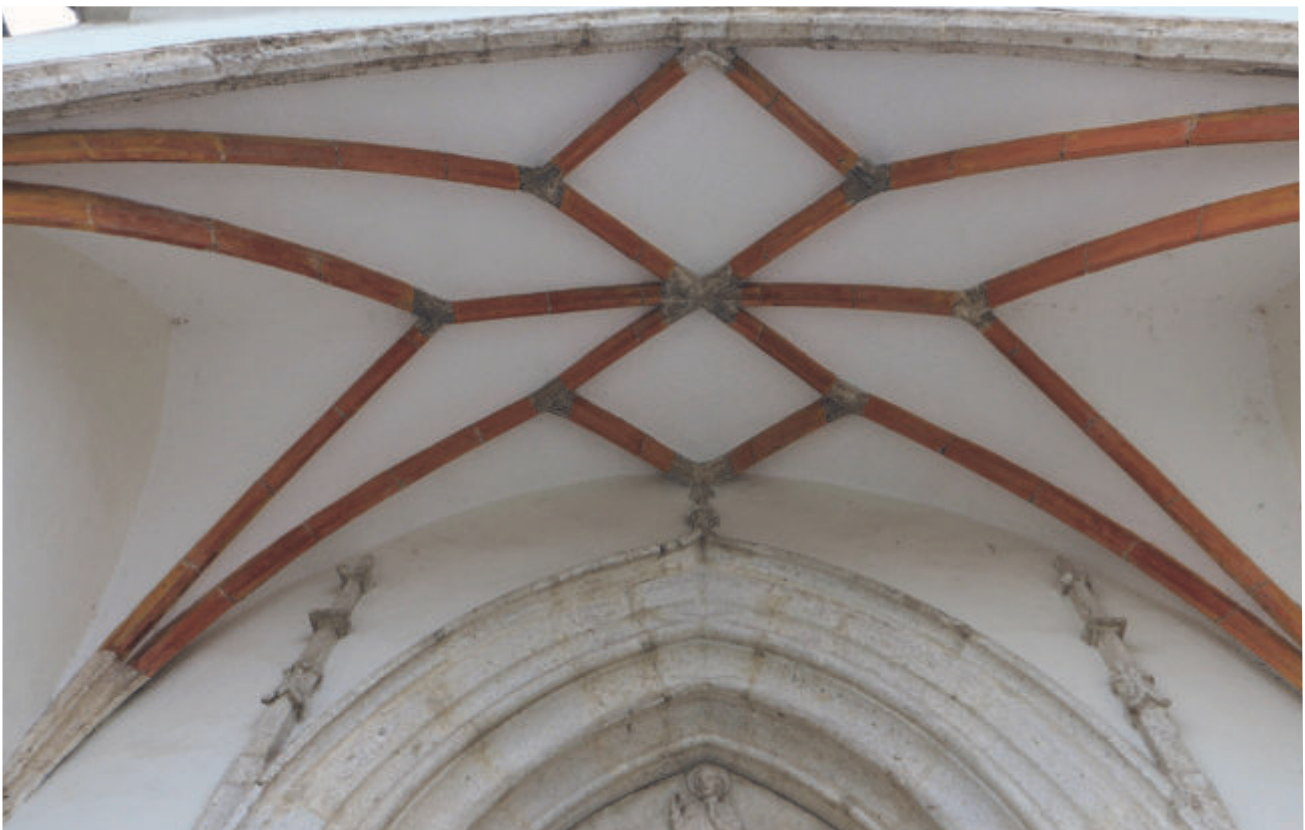
Langhaus, Südfassade, Anbau Stiegenaufgang modern nach vorne erweitert, gotischen Eingangsbau mit Netzrippengewölbe
