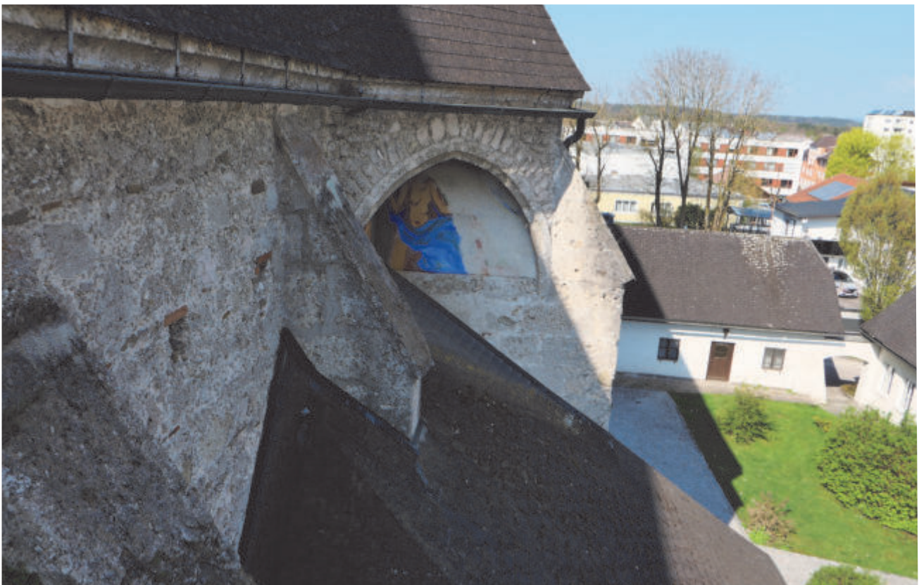
Langhaus, Ostabschluss, Strebefeiler, Ausbesserungen mit portlandzementhaltigem Mörtel, Trompengestaltung zwischen Langhaus und Ostabschluss über der Beichtkapelle
