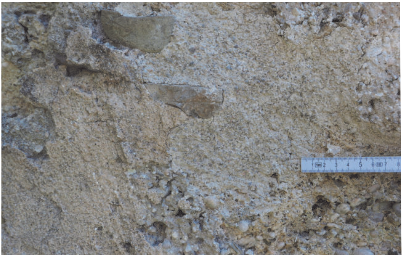
Musterfläche 3 (Langhaus, Süd, Sakristei, Westwand), Vorzustand, fertig, Detail
