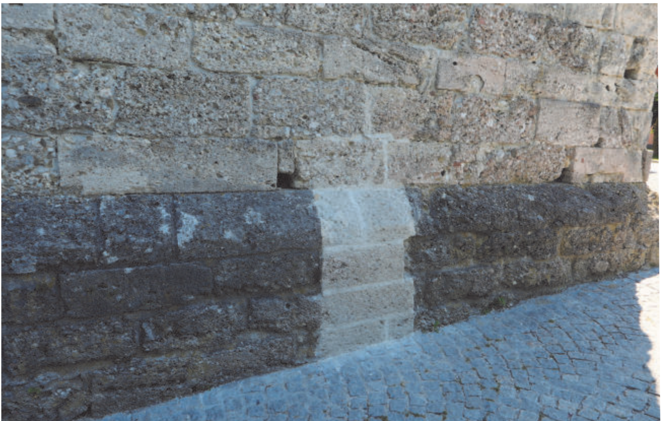
Musterfläche 2 (Turm, Westfassade, Sockel), Grobmörtel und Armierung, fertig
