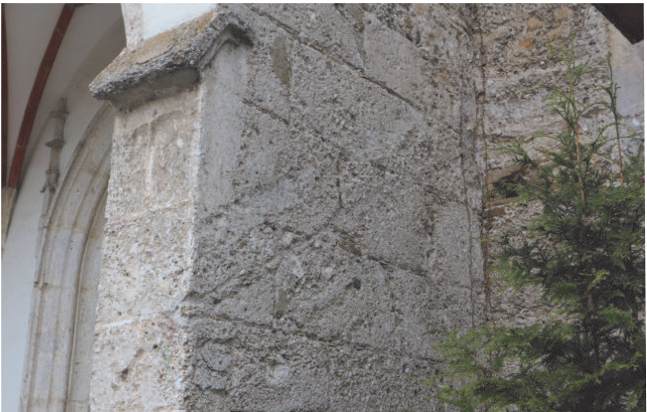
Langhaus, Südfassade, hier war der Ölberg angebaut, die Dachansätze zeichnen sich noch ab
