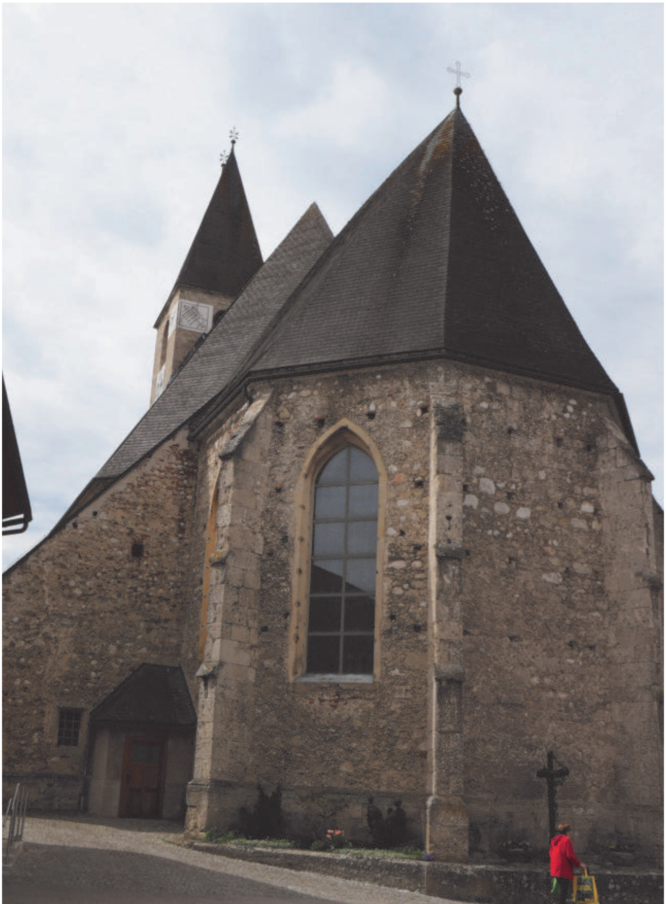
Langhaus, Ostabschluss, Ansicht Südost
