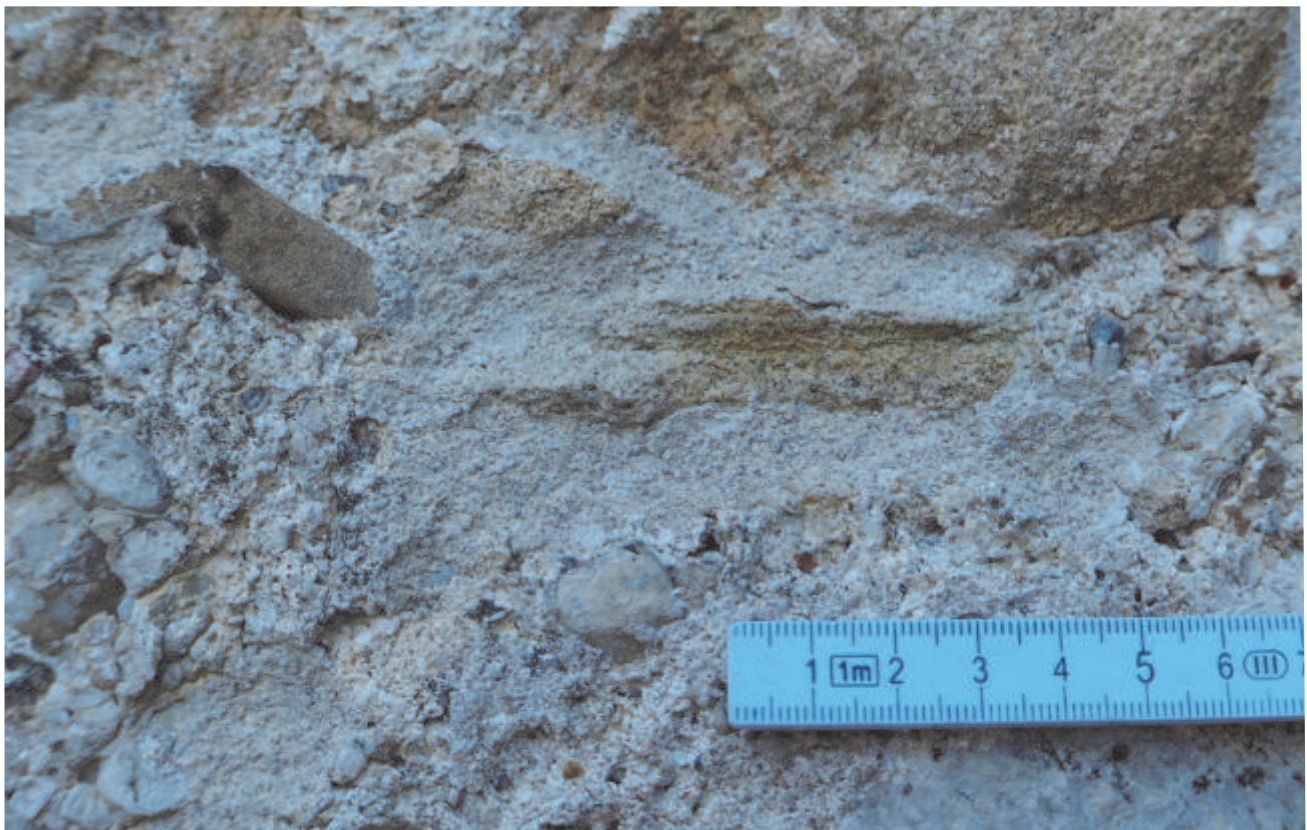
Musterfläche 1 (Langhaus, Westfassade, links), Vorzustand, Fertig, Detail
