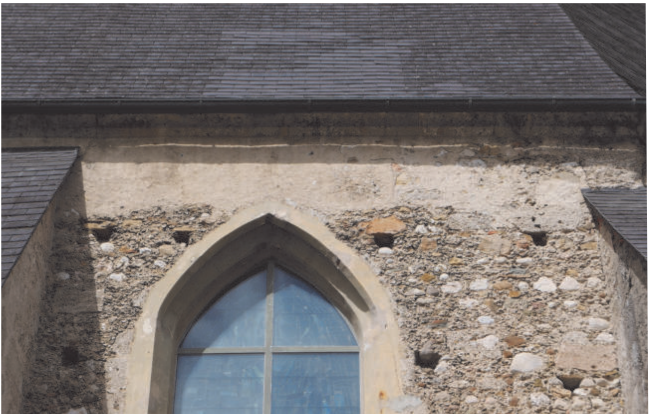
Langhaus, Südfassade, Bereiche über den linken und rechten Fenster
