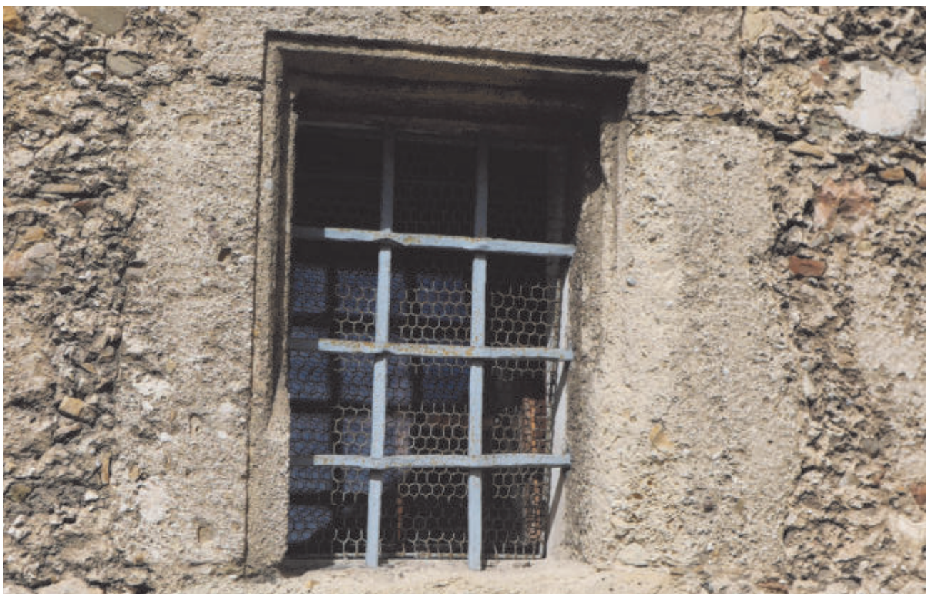
Langhaus, Südfassade, Sakristei, Gebäudekante aus Konglomeratblöcken, Strebepfeiler in der Westfassade integriert, Fenstergewände an der Südseite
