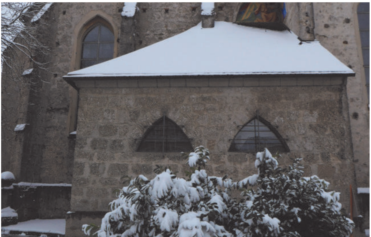
Langhaus, Nordfassade, Beichtkapelle, in den Bau eingebundener Strebepfeiler, Fassaden aus Konglomeratblöcken deren Ränder sind mit Zementmörtel verputzt, halbrund eingedrückte Fuge mit Fassung, Fotos Feb. 26
