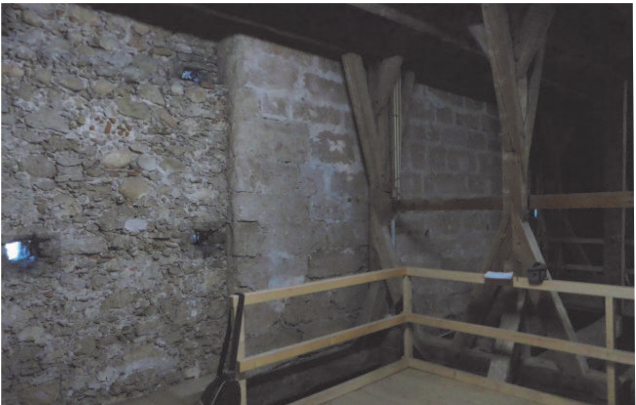
Turm, Ostfassade, Dachbodenraum mit Blick Richtung Westen, Turmfassade und Anschluss der Langhauswände
