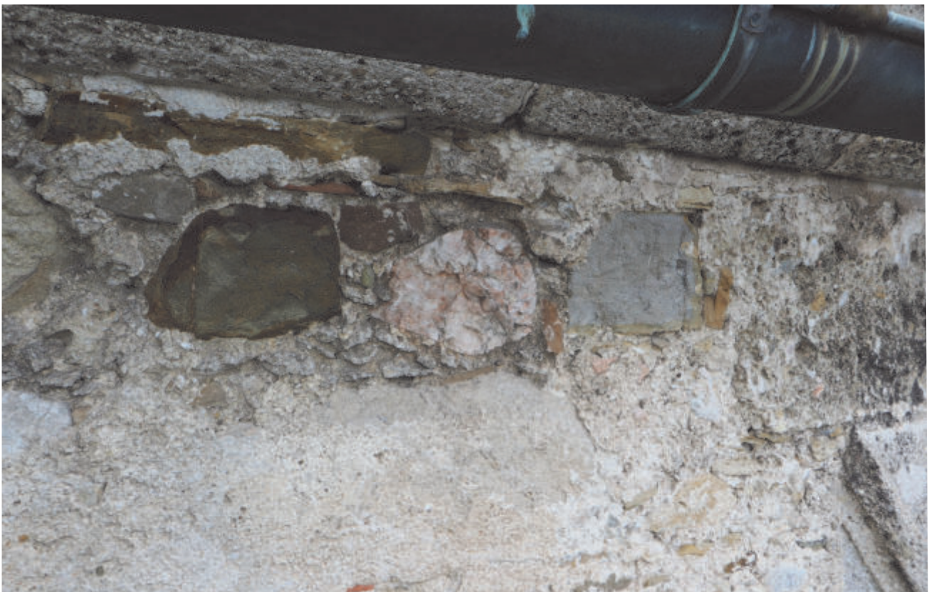
Langhaus, Nordfassade, Strebeböfeler, Pultfläche mit Zementputz geglättet, Traufengesims
