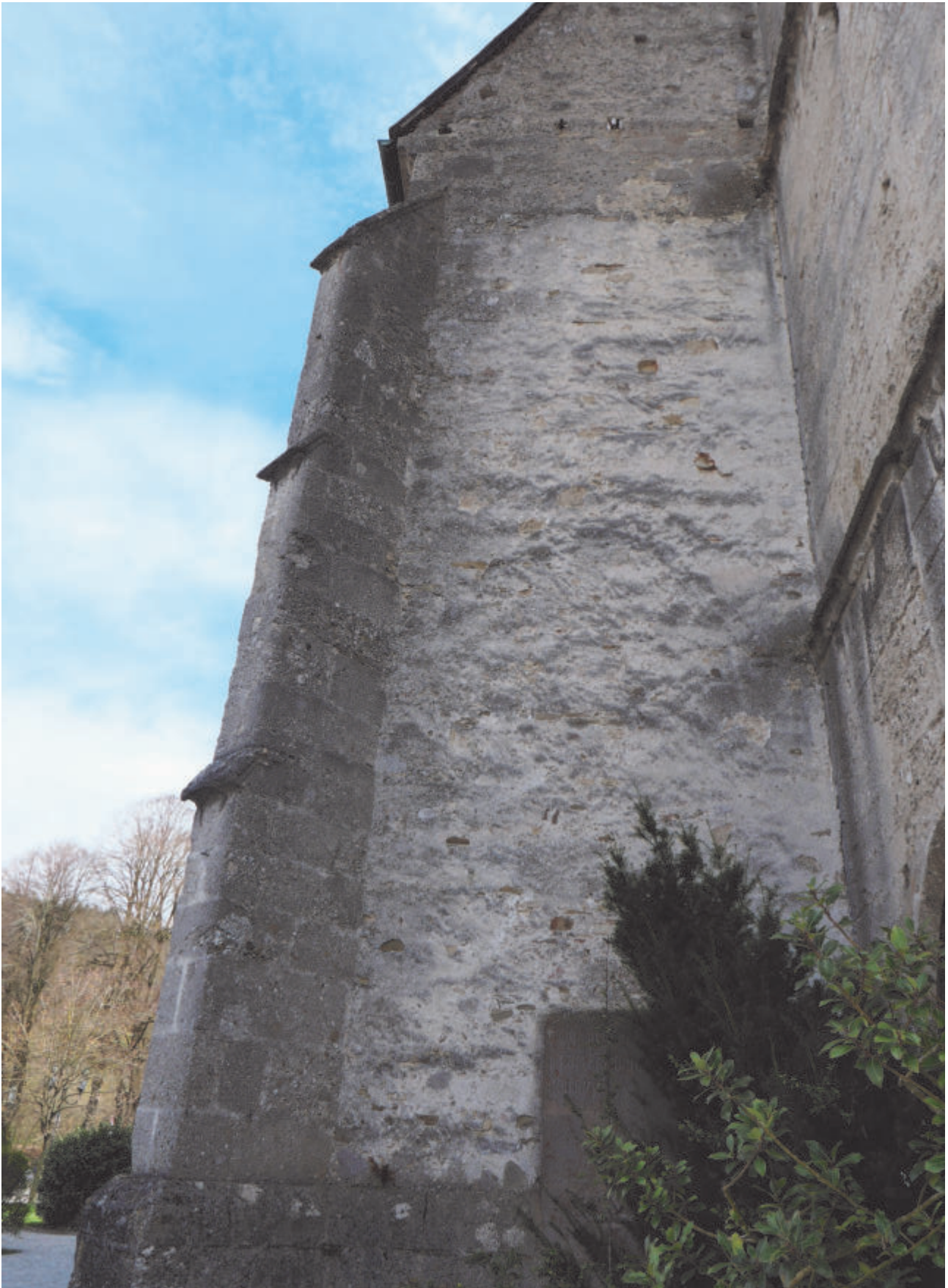
Langhaus, West, linke Fläche, Gesamtansicht
