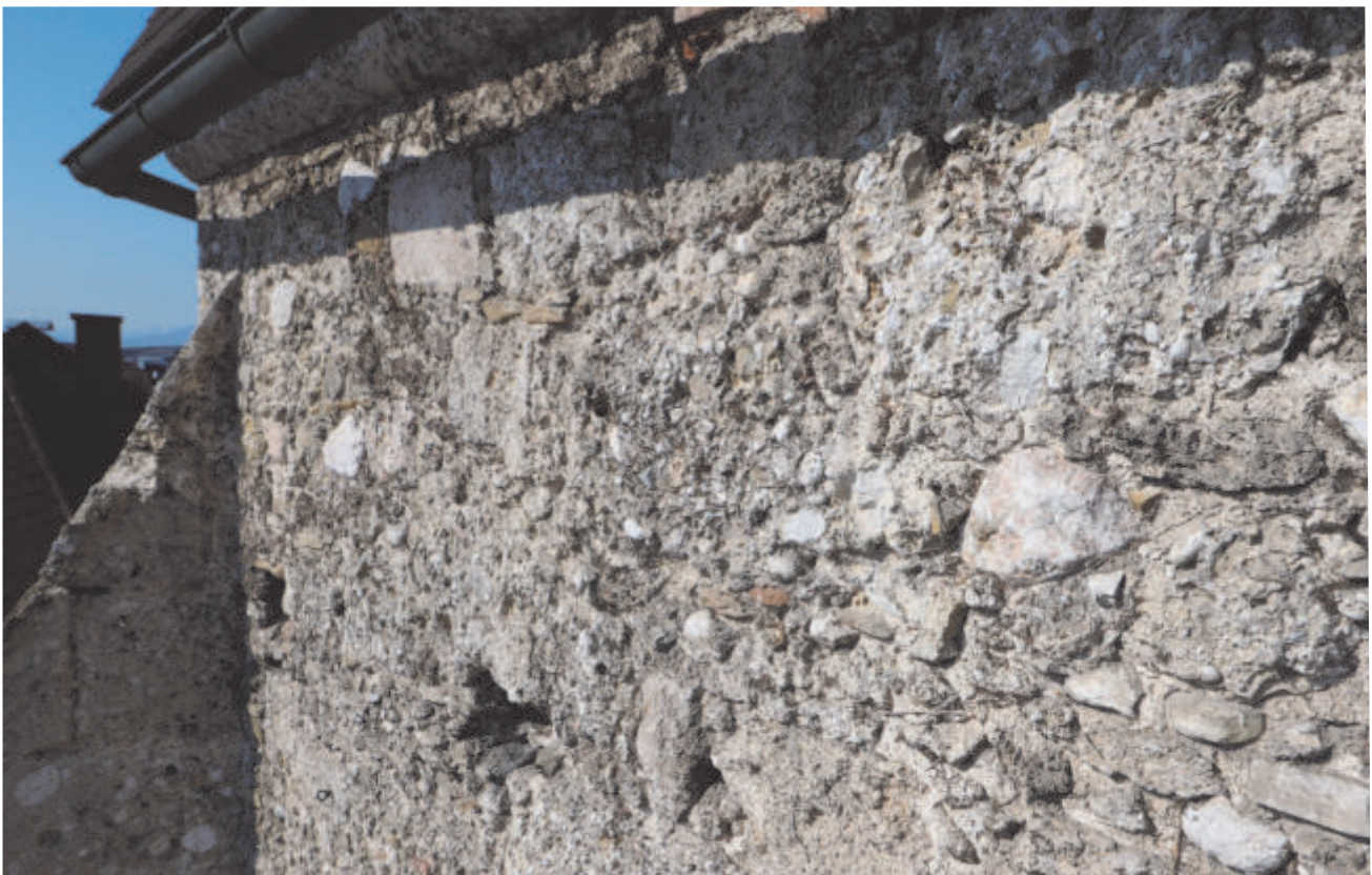
Langhaus, Ostabschluss, Strebeifeiler, biogener Bewuchs, Wandfläche
