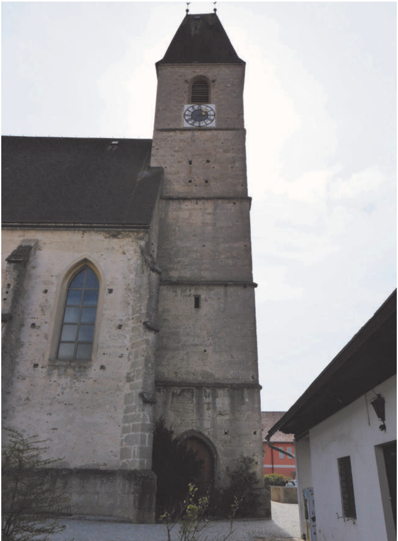
Turm, Nordfassade, Gesamtansicht
