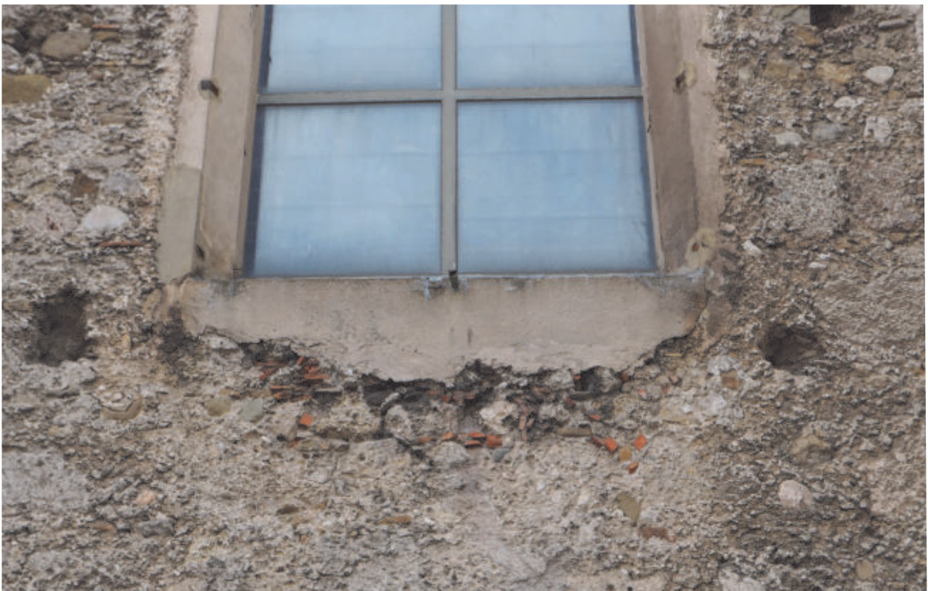
Langhaus, Ostabschluss, verputzte Fensterfaschen, Anschluss Dachrinne zur Sakristei, Unterkante Fensterfasche
