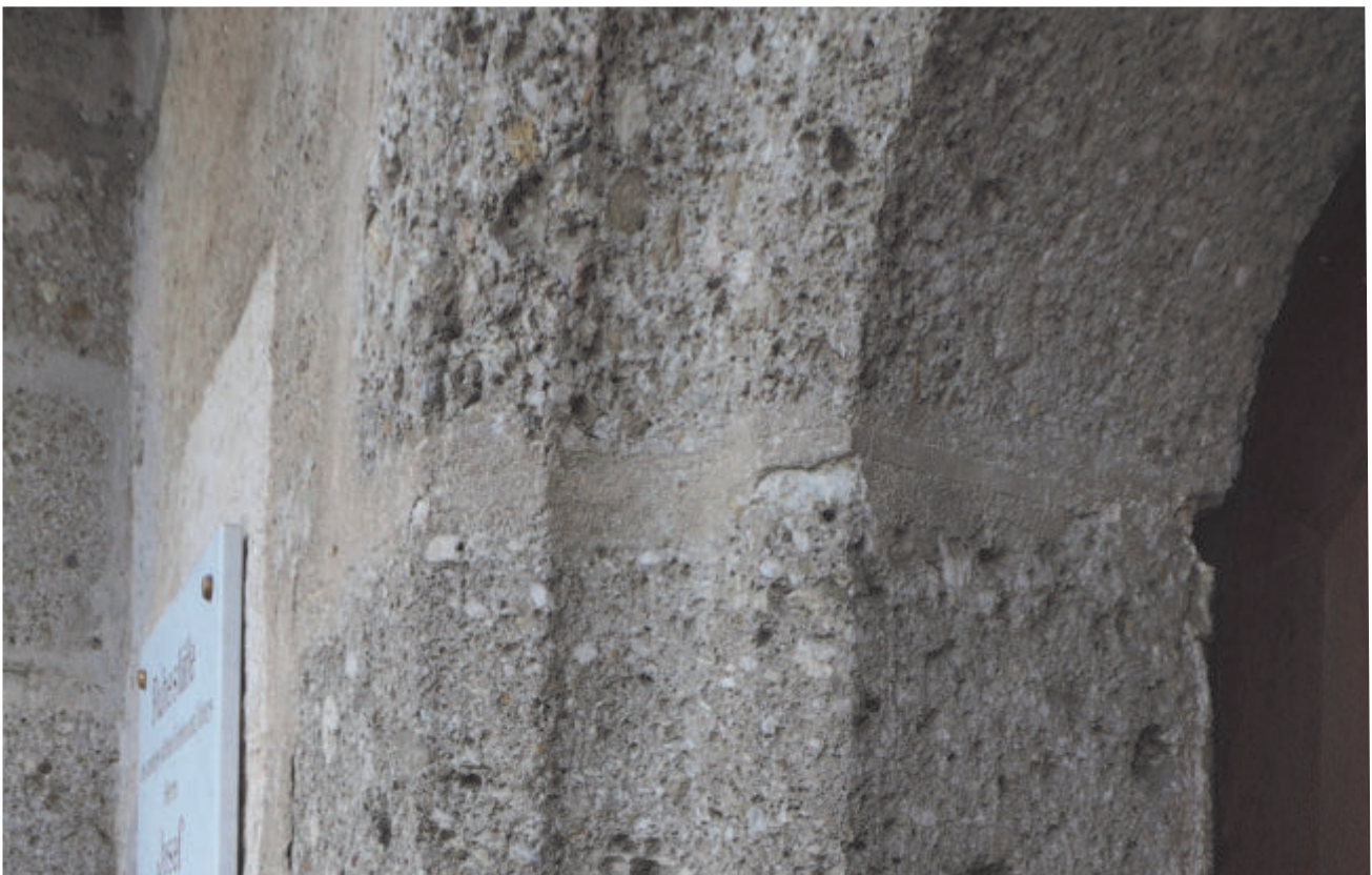
Langhaus, Nordfassade, Portal
