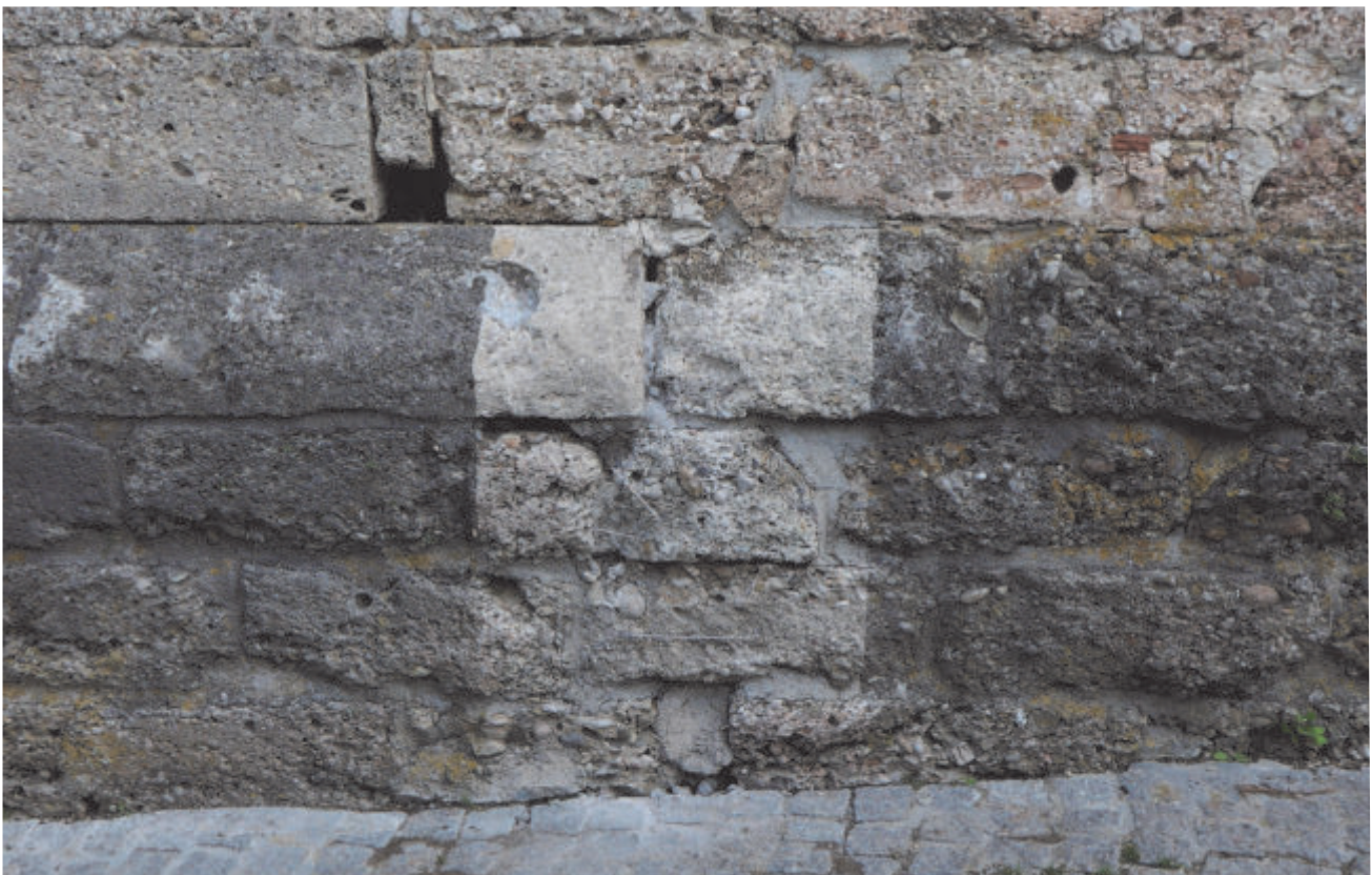
Musterfläche 2 (Turm, Westfassade, Sockel), Vorzustand, nach der Reinigung
