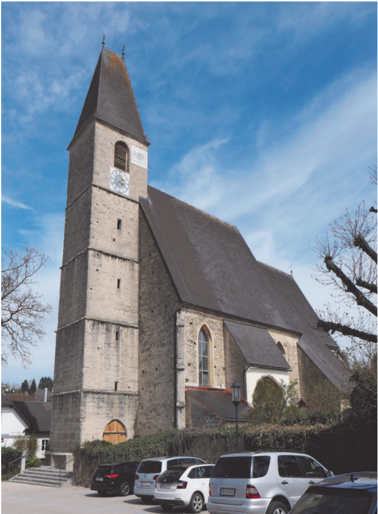
Kirchenschiff und Turm von Südwest
