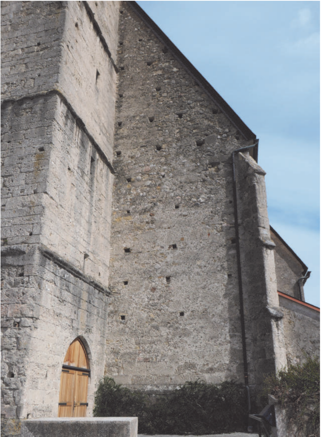
Langhaus, West, rechte Fläche, Gesamtansicht
