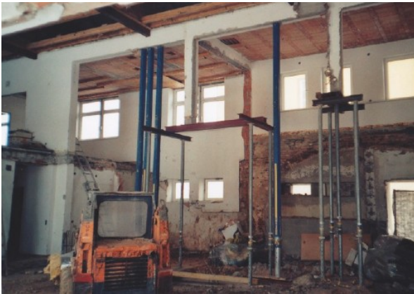
Umbau 2006 Durchbruch des Gewölbes und des ehem. Stiegenaufgangs
