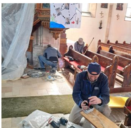
Drei Elektriker bei der Arbeit. Der vierte arbeitet in der Sakristei. FOTO: PUTZ
