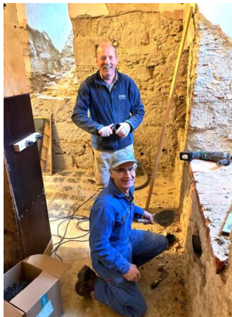
Arbeiten in der Sakristei und an der Mischmaschine.
