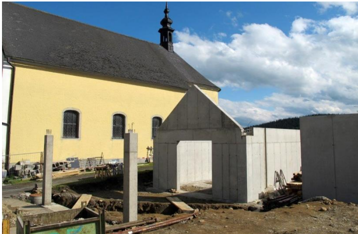
Die Bauarbeiten schreiten zügig voran. Foto vom 23.6.2015
