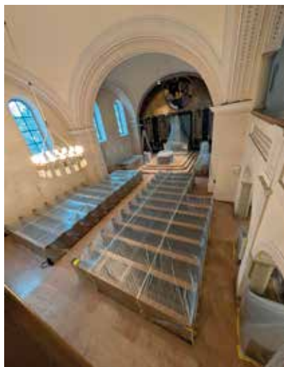
Die in der Kirche verbliebenen Teile wurden gegen Verschmutzung gesichert
