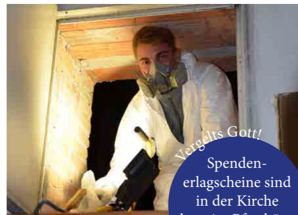
Firma Kickingger aus Unterweikersdorf bei den Arbeiten zur Kirchenbegasung.
