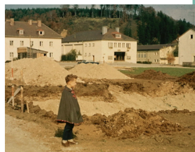
1964: Baubeginn für neues Pfarrzentrum mit Kirche und Pfarrheim
