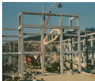
Erste Strukturen werden sichtbar
