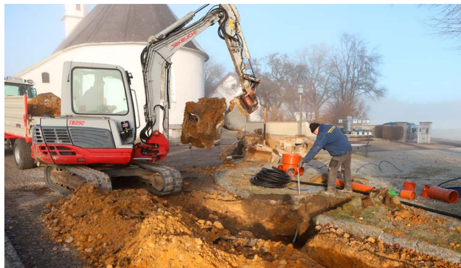
Arbeiten an der Neuverlegung des Wasser- und Kanalnetzes
