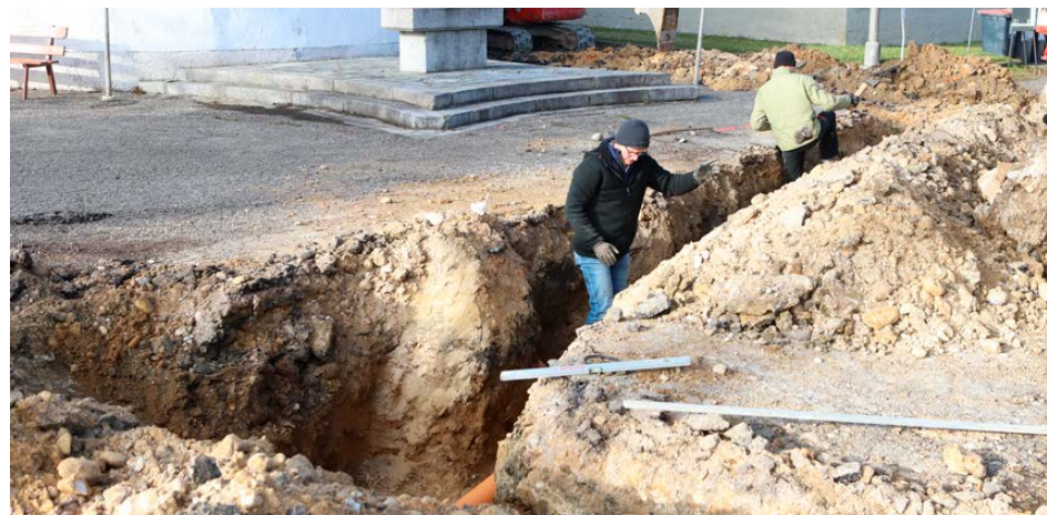
Arbeiten an der Neuverlegung des Wasser- und Kanalnetzes
