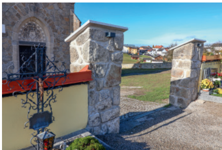
Friedhof Münzbach, Sanierung der Friedhofsmauer: Putz, Mauerflächen, Mauerkronen-Abdeckung, 2023. Foto: Robert Wöss
