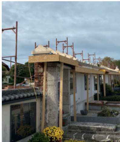
Sanierung der Friedhofsmauer in Taufkirchen/Trattnach, Foto: Günther Grundner
