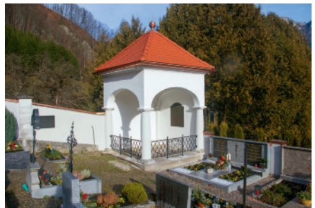
Friedhof Reichraming, Sanierung und Stabilisierung der Friedhofsmauern, Mauerkronenabdeckung, Sanierung und Restaurierung der Gruftkapelle inkl. neuer Dacheindeckung und kontrollierter Regenwasserableitung, 2019. Foto: Pfarre Reichraming
