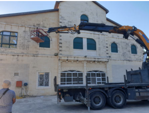
Fotos: Die Fassade vorher und nachher
