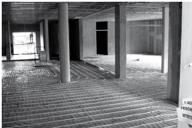
Die Fußbodenheizung ist verlegt...
