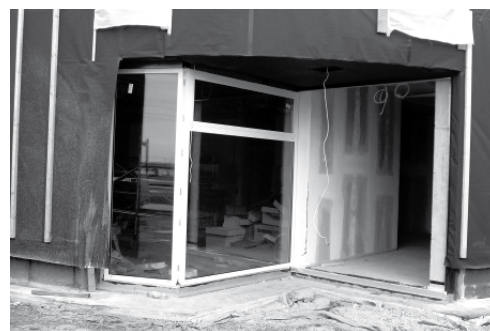
Fenster und Türen haben Einzug gehalten...
