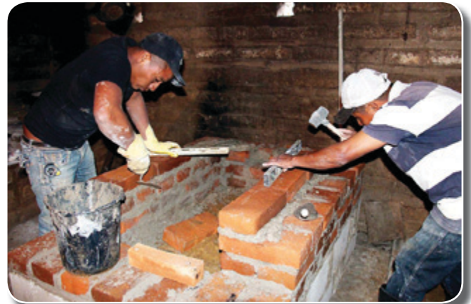
Ofensetzer beim Bau eines Tischherdes
