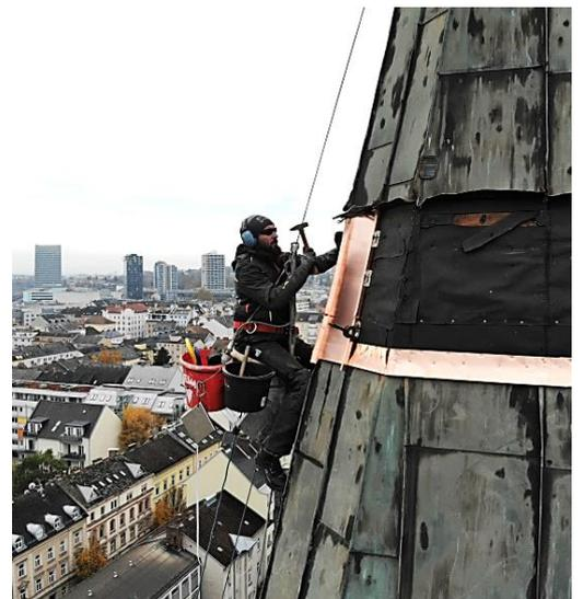
Die am Seil hängenden Arbeiter bauten zwei bandförmige Dehnungsfälze sowie Entlüftungsöffnungen ein und sanierten sämtliche undichte Stellen.
