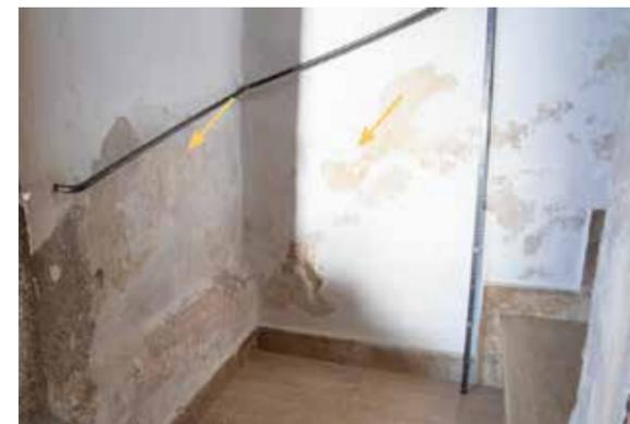
Salzschäden und Feuchtflecken im Sockelbereich des Emporenaufgangs
