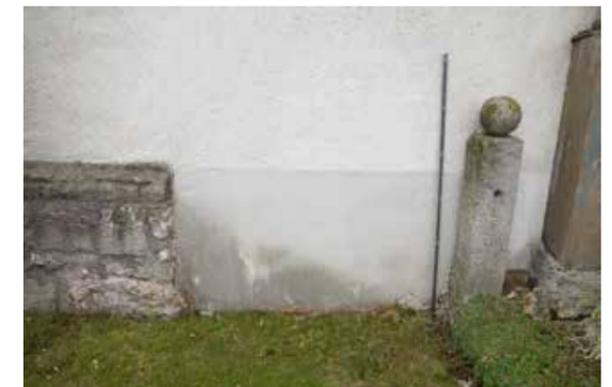
Feuchte Flecken im Sockelbereich an der Südostfassadenseite
