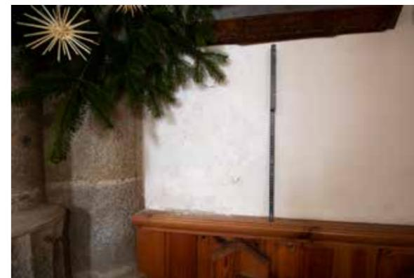
Feuchteschaden über Holzvertäfelung an der Südwand im Kirchenschiff
