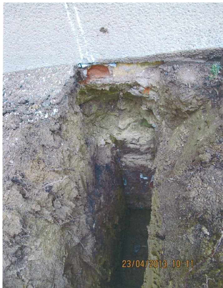
Abbildung 12: Foto vom Probeschurf 2013 nordseitig vom Turm (Quelle: Pfarre)
