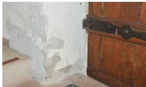
Feuchtigkeitsschäden im Sockelbereich
