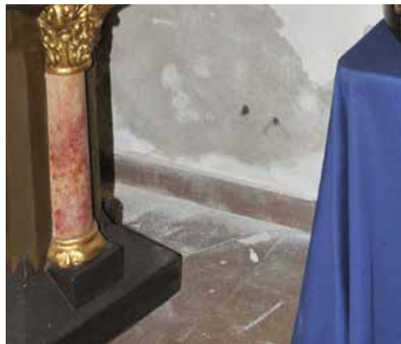
Bohrlöcher für Probeentnahmen
