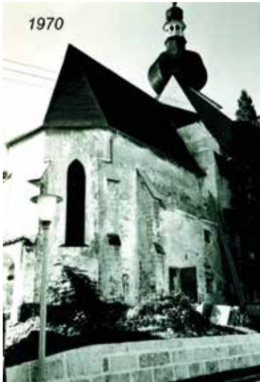
1970 Abbruch des Oratoriums und Abschlagen des Verputzes
