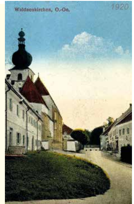
1920 alte Ansicht mit Fassadengestaltung
