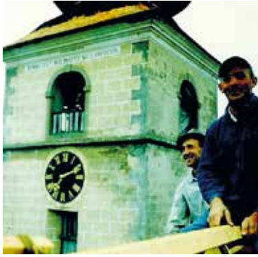
1968 Neueindeckung des Kirchendaches mit Eternit
