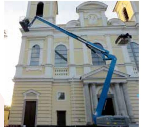
teilweise 2012 nicht durchgeführte Ergänzungsarbeiten schon wieder größere Schäden am Verputz oberhalb der Gesimse entstanden waren. Insbesondere in den Turmbereichen (unterhalb der Glockenjalousien) musste mehr Verputz entfernt, Verblechungen ergänzt und neu verputzt werden.
