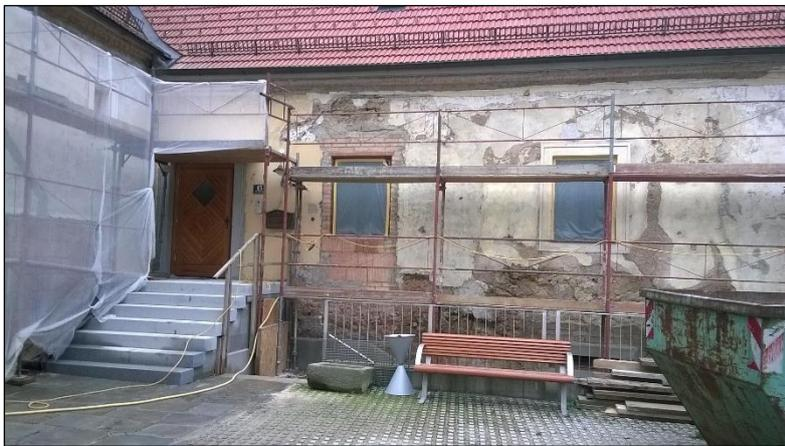
Schadhafter Verputz und Färbelung müssen entfernt werden. Nach den Ausbesserungsarbeiten ist eine Trocknungszeit notwendig. Mitte Oktober erfolgt die Färbelung.
