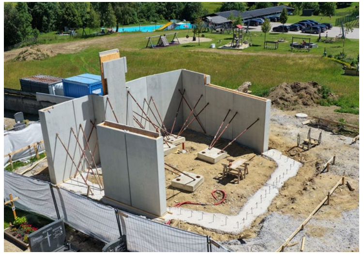
19. Juni: Die aufgestellten Sichtbeton-Elemente
