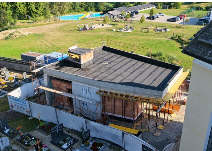
2. August: Die neue Halle von der Friedhofseite
