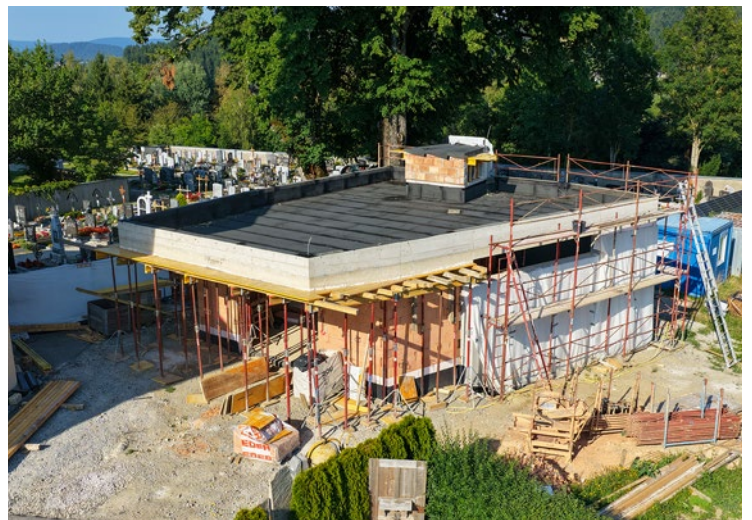
2. August: Die neue Halle von der Lauß-Seite
