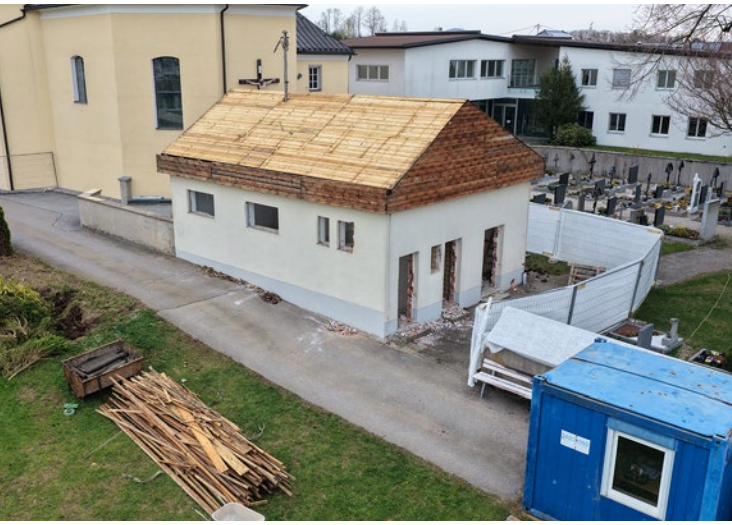
13. April: Die alte Halle vor dem Abriss
