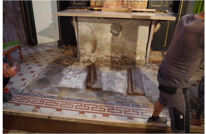
Die Stufen und der Aufbau des Hochaltares war schon baufällig. Es wird von einem Tischler neu stabilisiert und eingepasst.
