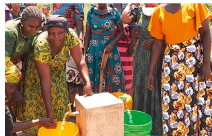
Wasserentnahmestelle von einem solarbetriebenen Brunnen
