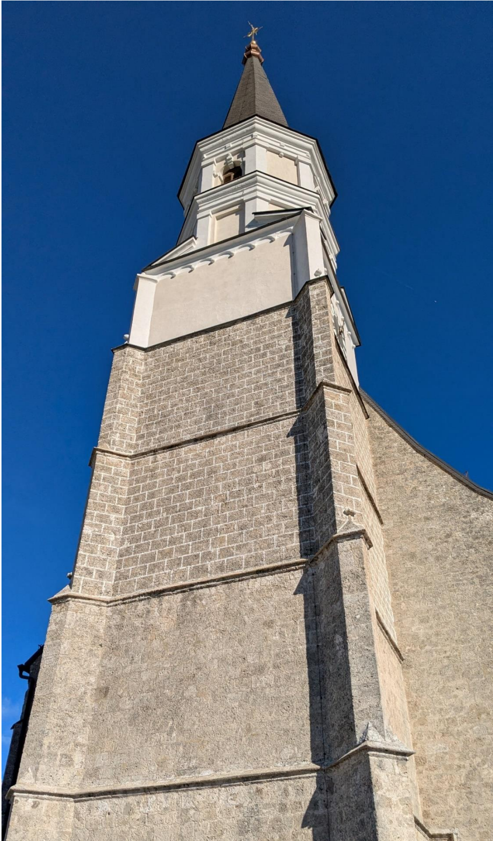
Schlussfoto der Generalsanierung des Kirchturmes 2024/2025
