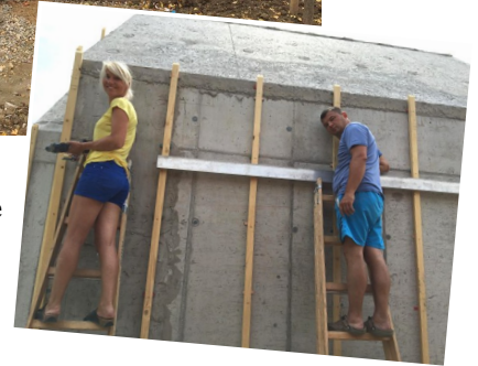
In der Bauphase
