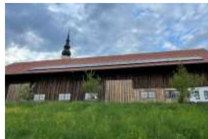
PV-Anlage am Pfarrstadl
