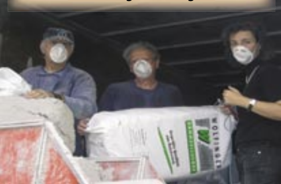
Das Dach des Großen Pfarrsaales wur- de mit einer Beschüttung aus präpa- riertem Altpapier isoliert. Schließlich muss man im Sommer schon für kalte Wintertage vorsorgen.
