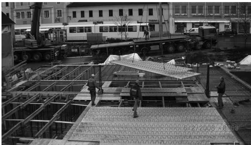
Die Kellerdecke wird geliefert
