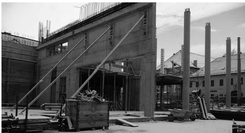
Blick in den Pfarrsaal und Foyer
